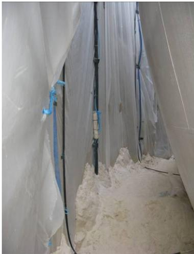
Figure 5 : Mise en place définitive des guides d'onde – Cette opération est réalisée tout au long de la phase d'ensablement de chaque sphère ; Sur la photo, à droite, la paroi de la sphère, à gauche, le mur de l'enceinte béton, sur lequel sont fixés les guides d'onde
