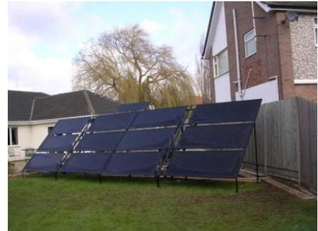
*Type de chauffage central solaire, source Enersols [2]*
