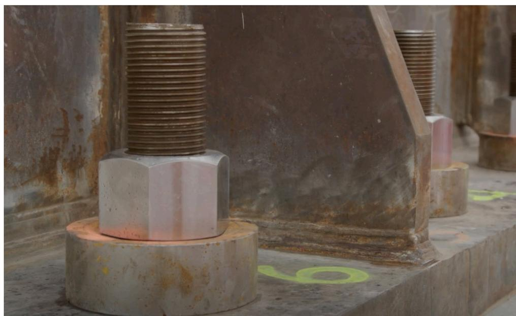
**Pour le levage** des embases gravitaires sur le chantier, quatre oreilles de levage sont fixées avec des assemblages vissés M83.
