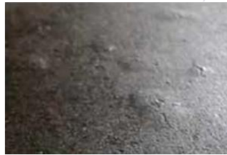
Surface interne du réservoir
